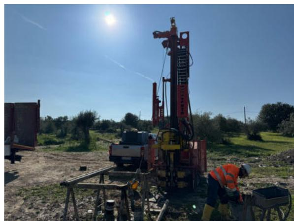
La perforazione è stata eseguita con l'ausilio di carotieri semplice con diametro 101 mm, con l'ausilio di fluido di circolazione.
